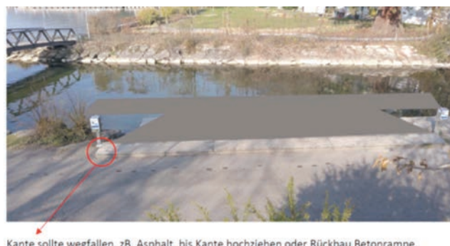
Kante sollte wegfallen, zB. Asphalt, bis Kante hochziehen oder Rückbau Betonrampe.
