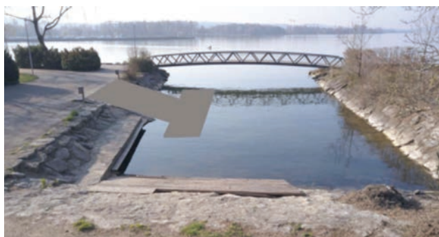
Kante sollte wegfallen, zB. Asphalt, bis Kante hochziehen oder Rückbau Betonrampe.
